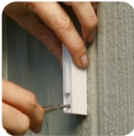
A continuación, retire el timbre de la pared y desconecte los cables.
